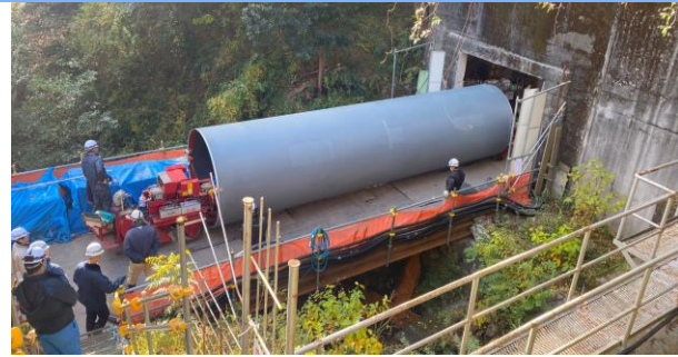
送水管更新事業
