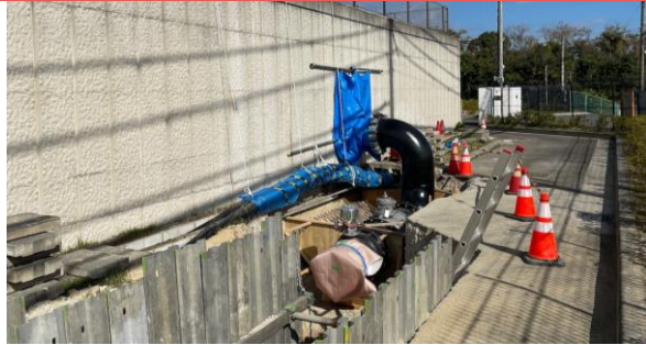
甲山調整池連絡施設工事
