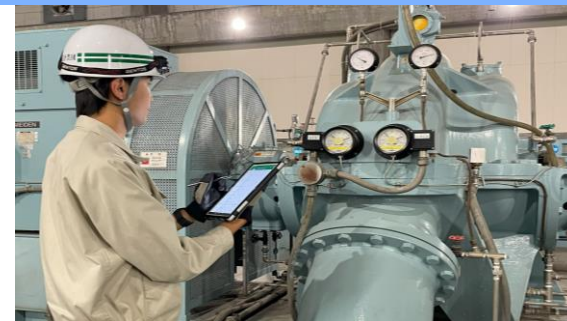
設備点検の様子
