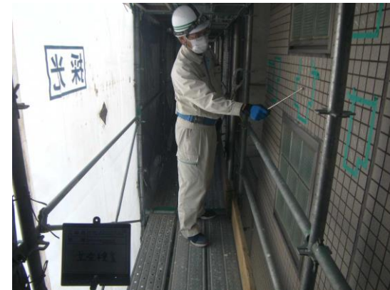
建築物の外壁検査
