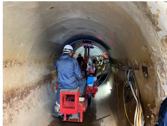
3期芦部谷送水路更新工事
