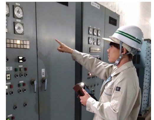
タブレットを利用した点検作業
