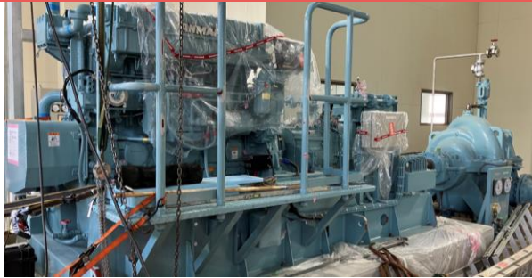
西宮ポンプ場送水6号用エンジン取替工事
