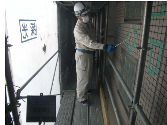
建築物の外壁検査
