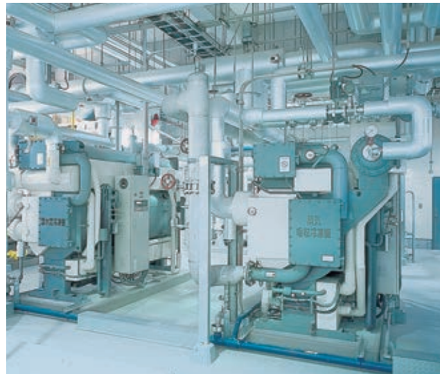
蒸気吸収冷凍機
