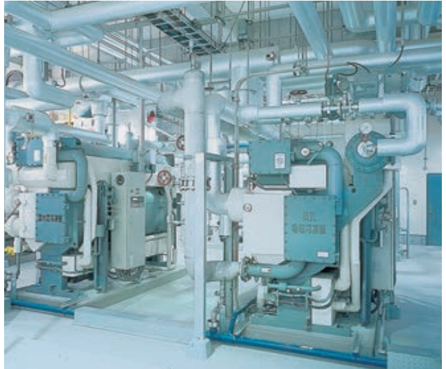
蒸気吸収冷凍機
